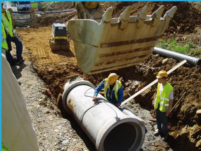
Travaux d'assainissement à Mulcey
