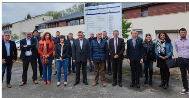
Les représentants du groupe SOS Seniors, les élus et les entreprises ont lancé les travaux d'extension de l'Ehpad devant le panneau de chantier. Photo RL
